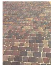
właściwe układanie kostki
